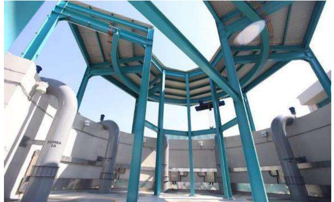
La Planta de Bombeo de **Vicente Guerrero** se proyectó con Seis (6) Bombas Sumergibles de Flujo Axial Indar H-700-701 + MF-355-8 / 145, bombeando un caudal total de **6.000 l/s** (137 MGD).
