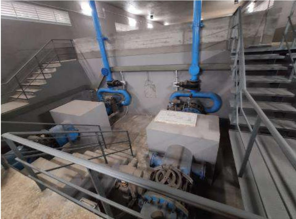
Tuberías de aducción y válvulas reductoras
